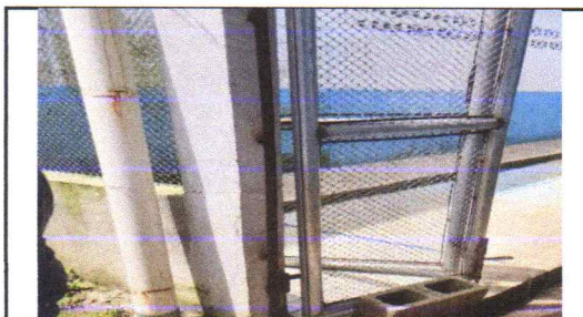
FOTO 18: Mantenimiento a portones de metal EN PATIO
