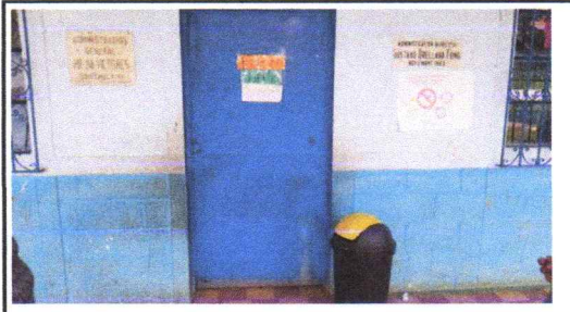
FOTO 10: Mantenimiento a estructura (lijado, cambio de tubo , cepillado, sujetones, aplicación de pintura) PUERTAS EN AULAS
