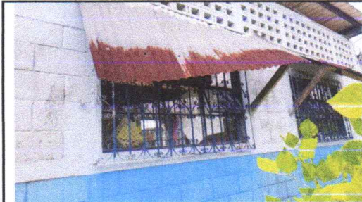
FOTO 9: Sustitución de lámina, por lámina troquelada aluzinc calibre 28 Y Sustitución de estructura de soporte de madera, por metal EN AULAS
