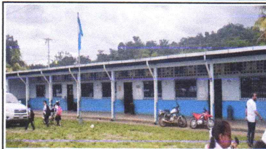
FOTO 14: Pintura en muros exteriores e interiores EN AULAS
