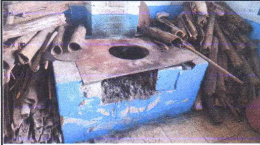
FOTO 7: Sustitución de estufa rural (completa) incluye chimenea y plancha de metal EN COCINA
