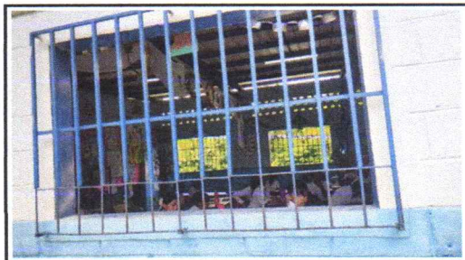
FOTO 11: Fabricación e instalación de balcones de hierro en ventana
