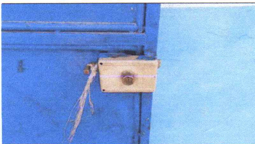
FOTO 5: Sustitución de chapa EN COCINA
